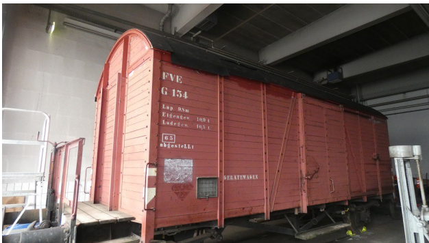
"Oppeln" G 154 beim Anbringen der neuen Dachhaut.
