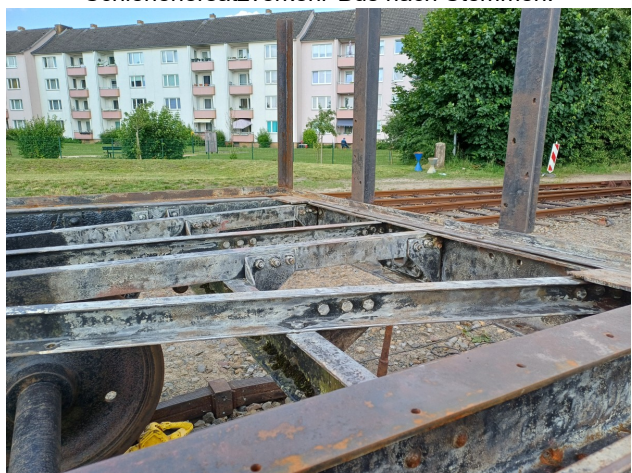
Fortsetzung der Schleifarbeiten am Gw 102.
