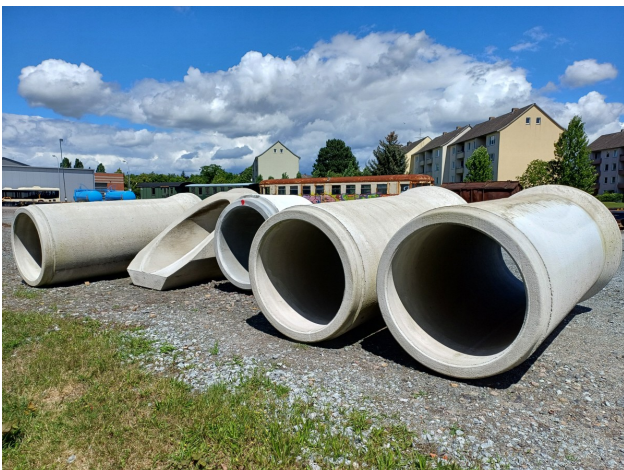
Die neuen Betonröhren für den defekten Grabendurchlass liegen bei der VWE in Verden bereit für den Einbau.
