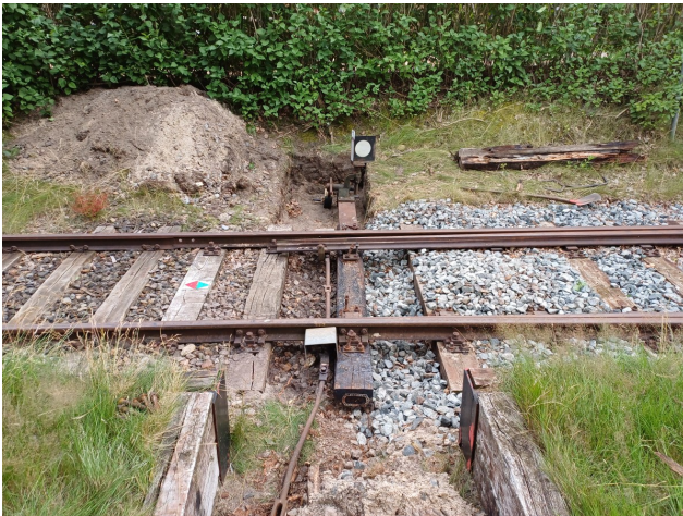
Austausch der maroden Weichen-Stellbockschwelle in Neddenaverbergen.
